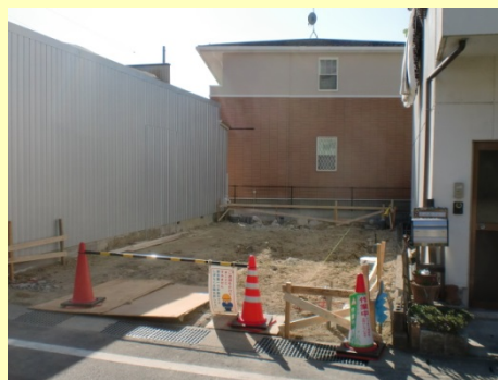
解体工事完了
