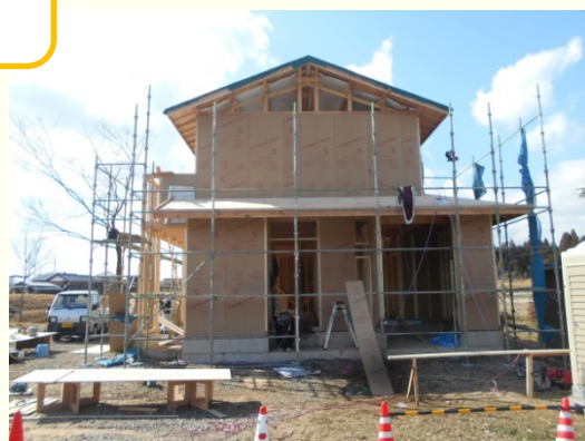
T 住宅新築工事 2 軒 上棟完了
