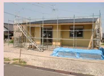
屋根工事(8月中旬)
