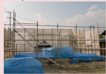
外部先行足場
