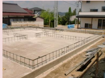
ベースコンクリート打設
